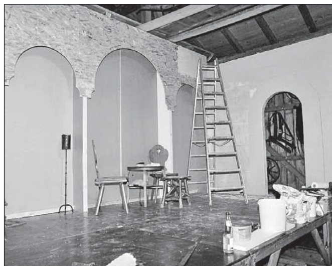
Noch müssen die Bühnenbildner die Wände verputzen und streichen.
